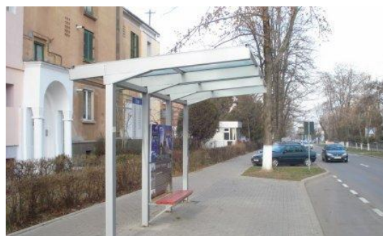
Figura 60 - Stație TP. Sursa foto: Google Maps
