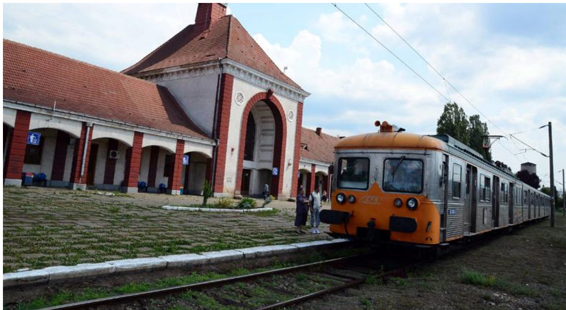
Figura 39 - Clădirea gării din Hunedoara
