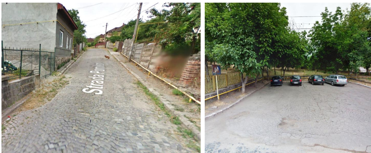
Figura 32 - Drum și parcare în imediata vecinătate a Castelului, în stare foarte avansată de degradare
