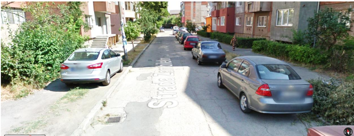
Figura 31 - Strada Zambeilor: stradă în stare rea, cu profil îngust ce poate fi transformat în ocazional carosabil (trama secundară). Parcare ad-hoc pe aliniamentul verde. Sursa – Google Maps
